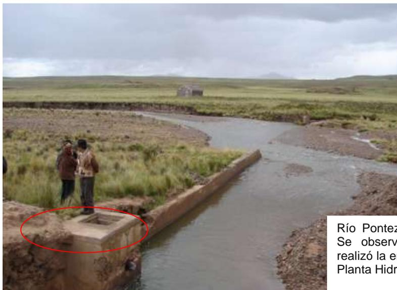
Río Pontezuelo, comunidad Sicuipata. Se observa el devío de agua que realizó la empresa para llevar agua a la Planta Hidrometalúrgica de Corocoro.
