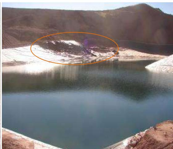
Se observa deterioro de la geo-membrana protectora del suelo del dique de colas - foto tomada en agosto 2010
